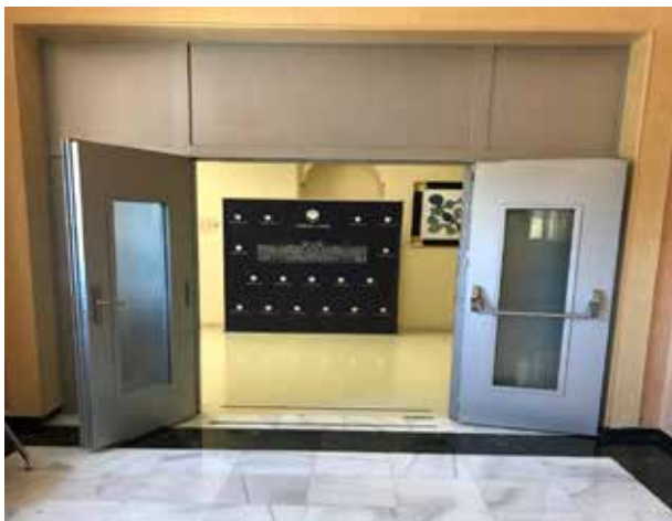
Fuente: Imagen recogida por la autora durante su visita a la UCO.
