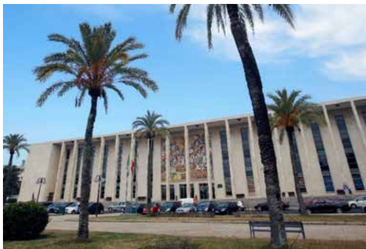
Fuente: Imagen recogida por la autora durante su visita a la UCO.
