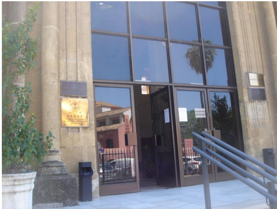
Imagen 57. Fachada del edificio de la unidad para la igualdad, US
