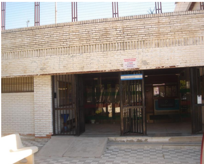
Fuente: Imagen recogida por la autora durante su visita a la UMA
